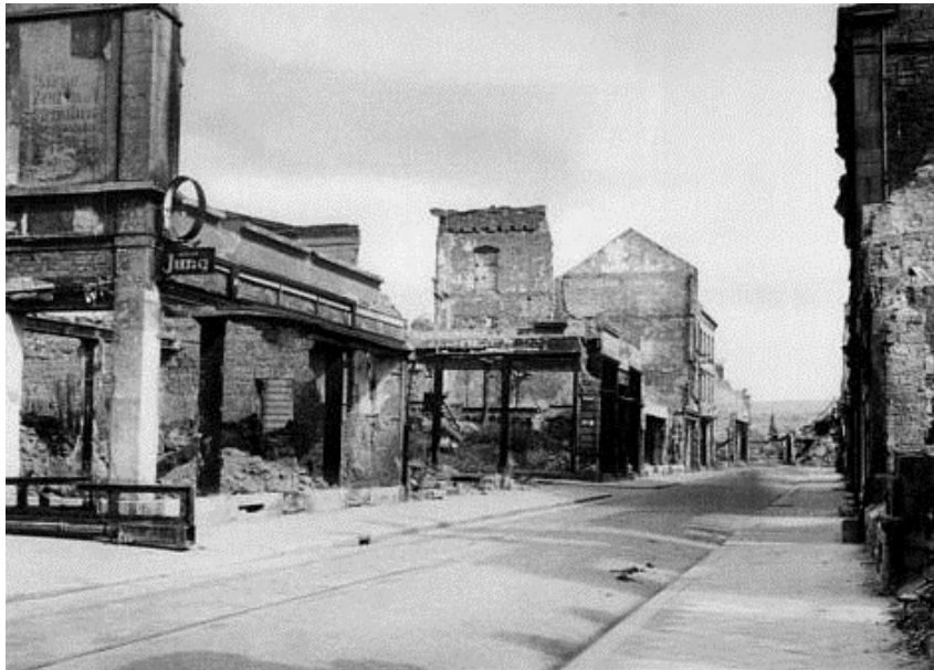
Die Fackelstraße im Jahr 1946. Auf der linken Seite Richtung Marktstraße steht fast kein Haus mehr. Vorn links die Bürohandlung Jung. Bei dem hohen Gebäude in der Bildmitte handelt es sich um die Hauswirtschaft Orth Am Altenhof 14.
