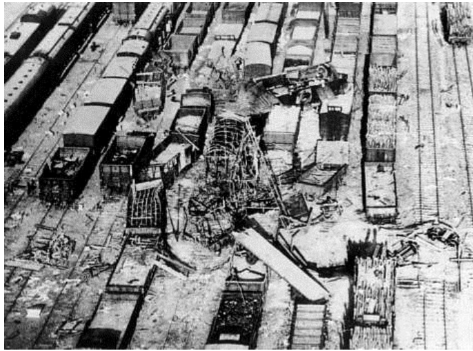
Zerstörte Güterzüge auf dem Rangierbahnhof Einsiedlerhof.
